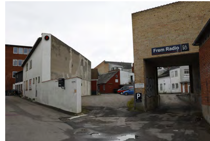
Eksempel på baghuse på bagsiden af Ringstedgade, mod Rådmandsparken
