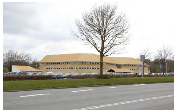
Næstved Kommunes administrationsbygning nord for Rådmandshavevejen
