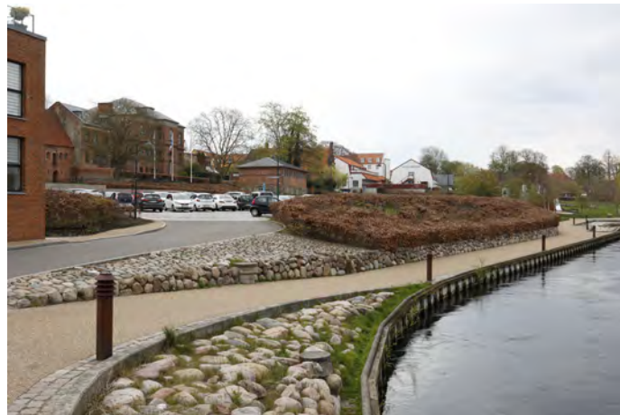
Parkeringsanlæg ved Susåen ved Havnegade. Landskabsbearbejdning og bøgehække spærrer for oplevelsen af åen og af terrænets hældning.
