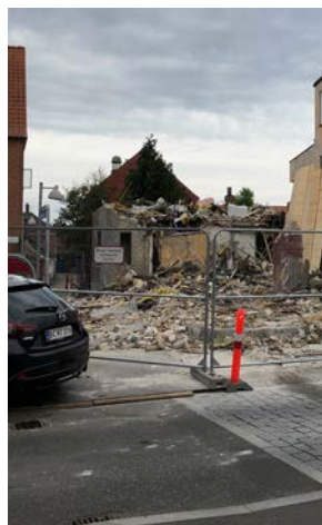
Gadeforløb med nedrevet hus. Foto Substrata
