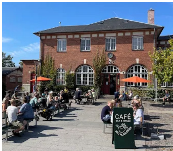
Reference fra Humlebæk Station: Transformation af eksisterende stationsbygning, der er åbnet op inde og ude med café og er blevet et socialt mødested.
