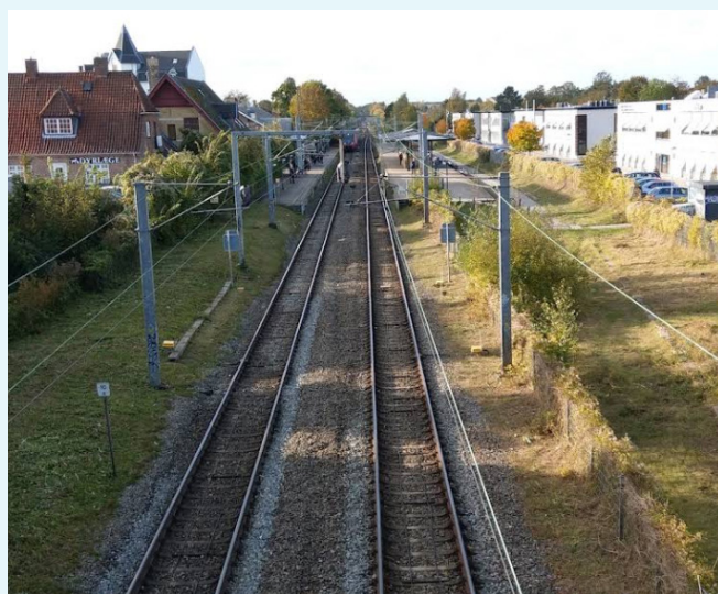
Kig fra Gentoftegade vejbroen i retning mod Jægersborg Station med de nyere erhvervsjendomme (opført 1999 – 2002) ved Smakkedalen til højre.
